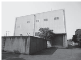
福田東排水機場
