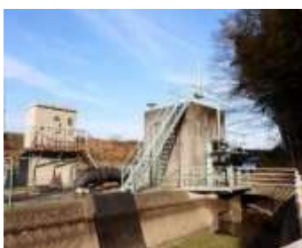
真備慈源寺排水機場
